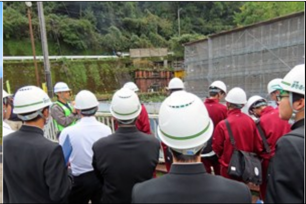
11.12 建設現場の魅力体験学習 (マイントピア別子) 新居浜建設業協同組合 工業系列
